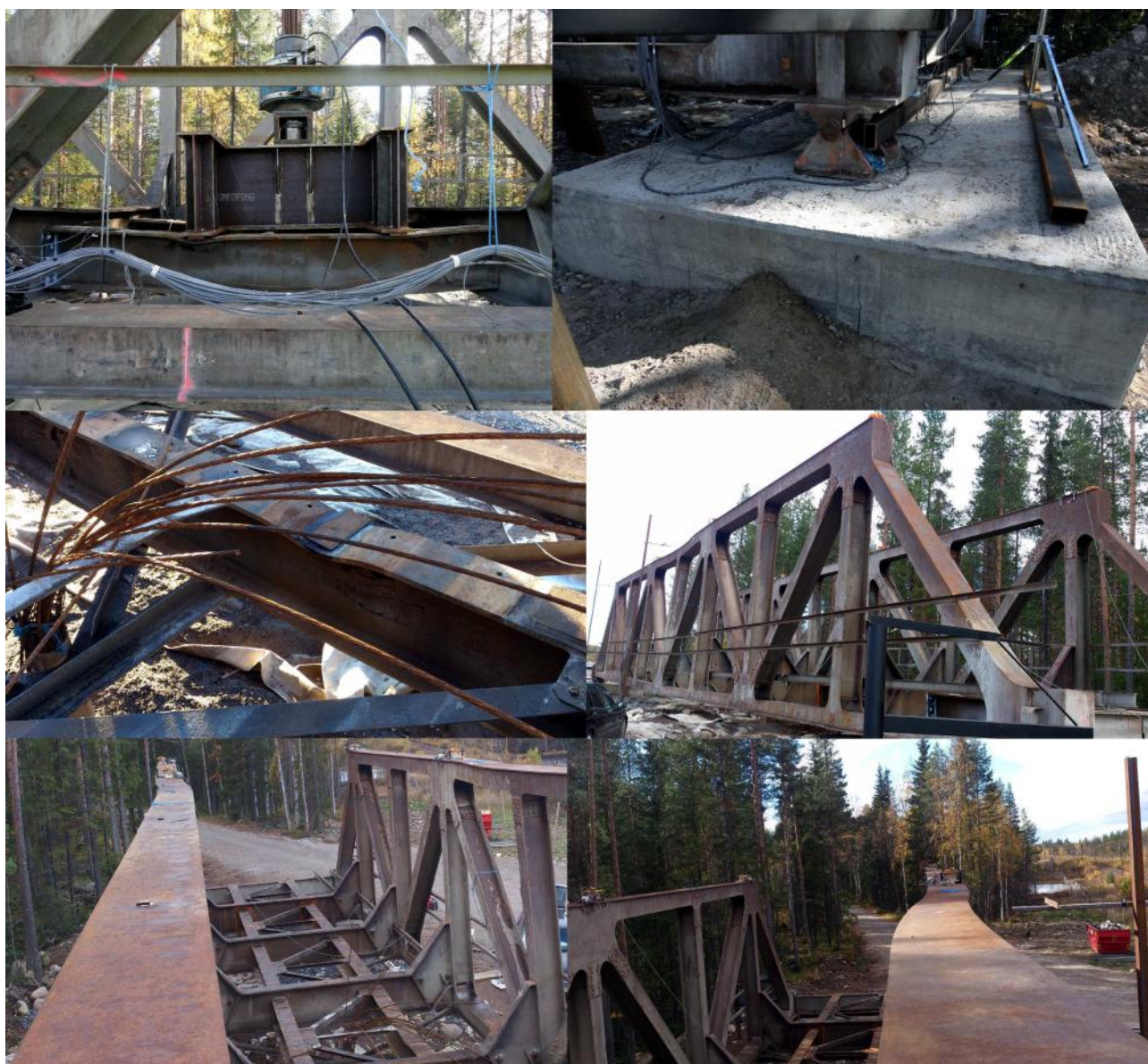
Figur 27: Bron utsattes avslutningsvis för gradvis ökad belastning upp till 1329 ton, då plastisk deformation inträdde. Övre balkarna vek sig inåt, flänsarna på de undre balkarna under domkrafterna vek sig och även betongfundamenten som bron vilade på hade fått sprickor.
